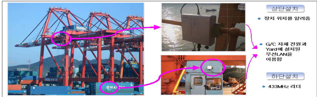
자료 : 최종희, 김수엽, 이호준 (2007), “항만물류 선진화를 위한 RFID 기술 도입 방안”, 한국해양수산개발원 [그림 6] Container Crane RFID 장비 설치 사례
